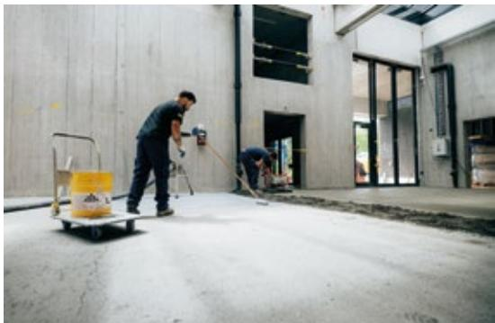
Die Tragschicht des Hallenbodens wird eingebracht.
