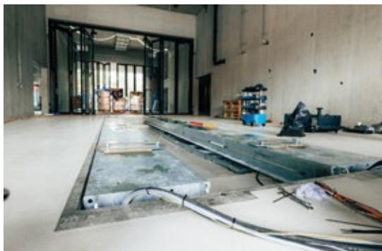
Die Hebebühne trägt Lasten bis zu 34 Tonnen Gesamtgewicht.
