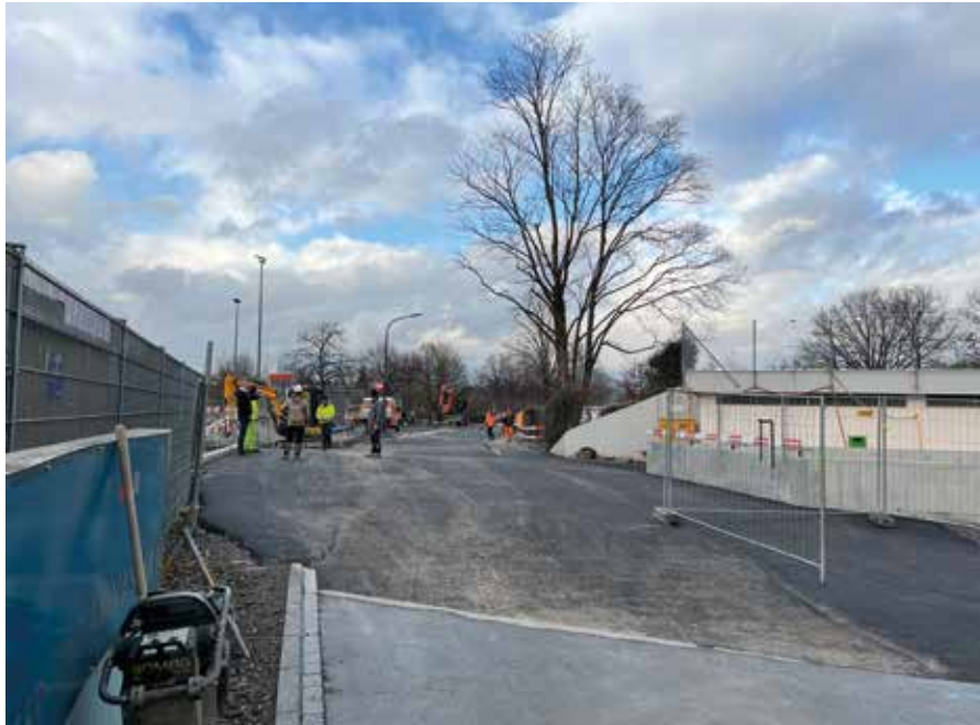
Auf der Schaanerstrasse wurde intensiv gearbeitet.
