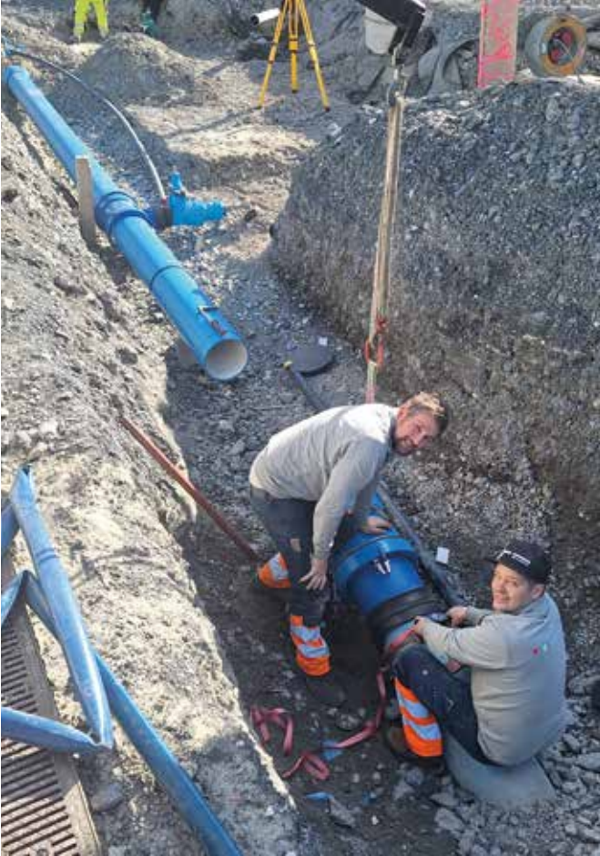
1'746 Meter an neuen Wasserleitungen wurden 2024 erstellt.
