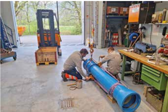
Die Wasserrohre werden vor dem Einbau in der Halle vorbereitet.
