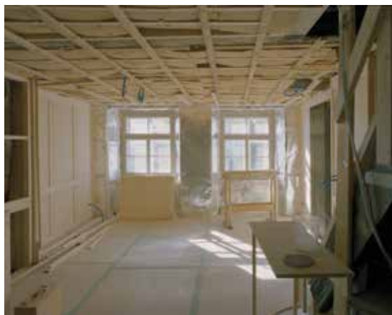
Die denkmalgeschützte Hofstätte Hintergass wurde komplett saniert.
