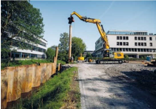
Für die Arbeiten war schweres Gerät im Einsatz.
