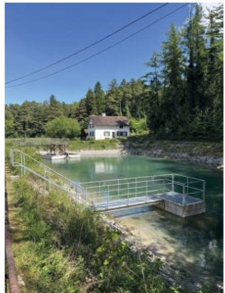
Speicherbecken im Oberen Möliholz, 2026.
