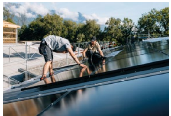
Die Photovoltaikanlage wurde auf dem Stalldach des Riethofs montiert.
