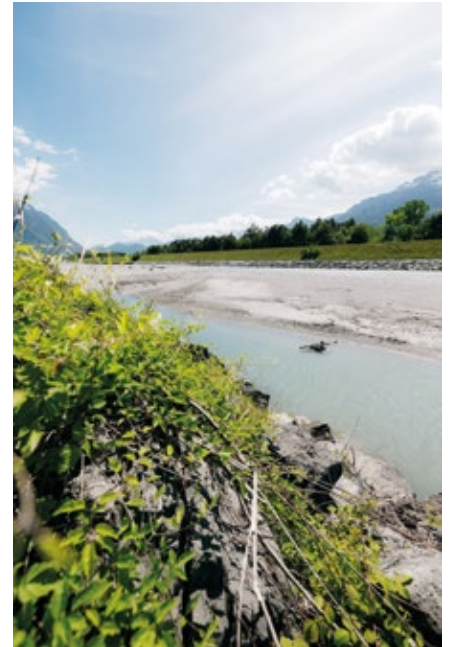
Der Dammbau beim Rhein.
