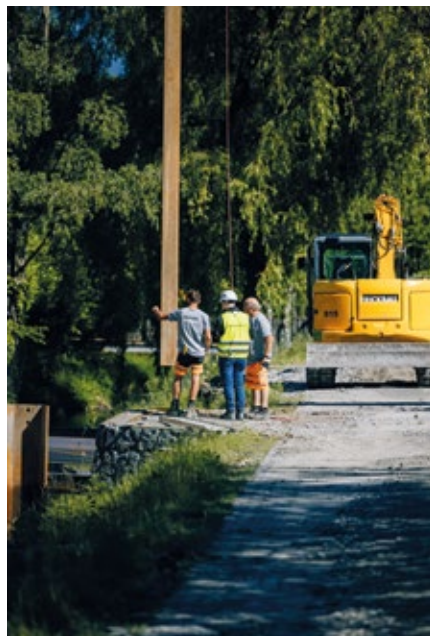
Spundbohlen wurden am Giessen einvibriert.
