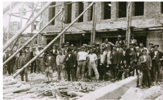
Aufrichtfest beim Bau 1933 (Landesarchiv).
