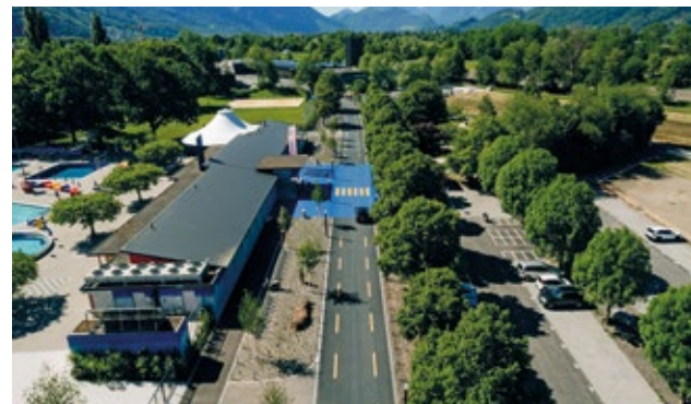
Radstreifen mit einer Breite von 1.5 Metern wurden beidseitig auf der Strasse angebracht.
