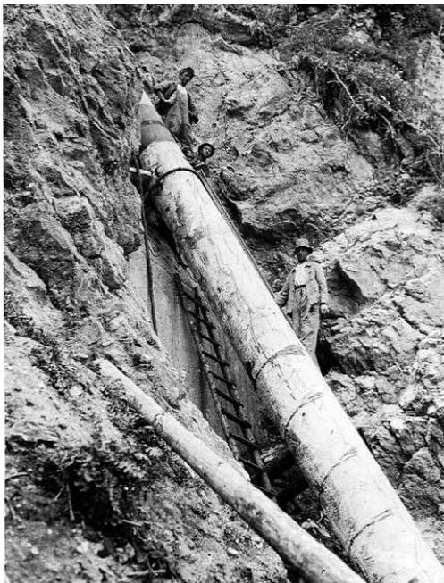
*1947 – 1949 wurde das Saminawerk gebaut. Unser Bild zeigt die Rohrverlegung vor der Zentrale.*
