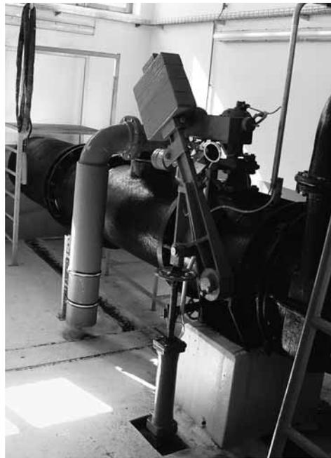
*Apparatekammer Masescha: Übergang Druckstollen in Druckleitung.*
