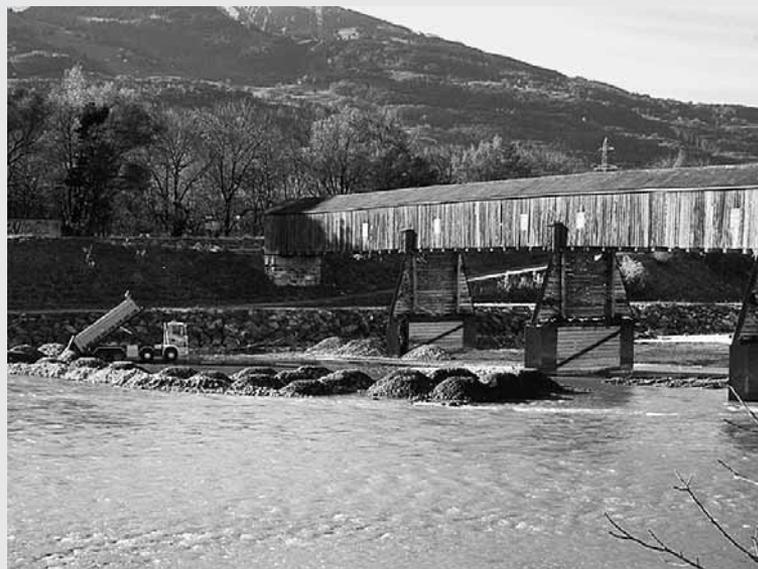
Wie wir bereits im letzten «Einblick» berichteten, wird die alte Rheinbrücke zwischen Vaduz und Sevelen zurzeit saniert und instand gesetzt. Die Arbeiten am Unterbau (Fundamente und Pfeiler) sind soweit fortgeschritten, dass die Instandsetzung des Brückenkörpers in Angriff genommen werden kann.
