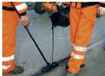
*Die Risse werden sorgfältig mit flüssigem Bitumen ausgegossen.*
