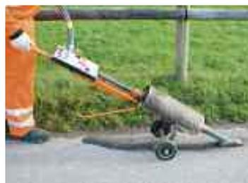
*Die Risse werden mit einem Spezialgerät porentief gereinigt.*
