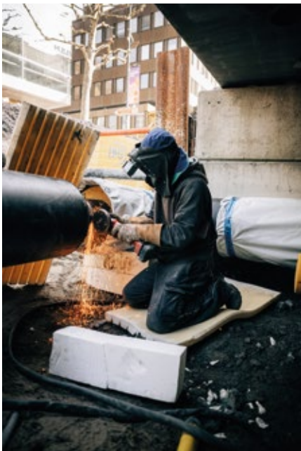
Fernwärme- und Fernkälteleitungen werden in der Äulestrasse verlegt.
