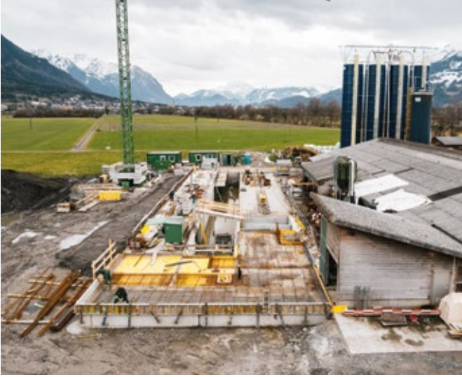
Die Arbeiten am neuen Stallbereich sind schon weit fortgeschritten.
