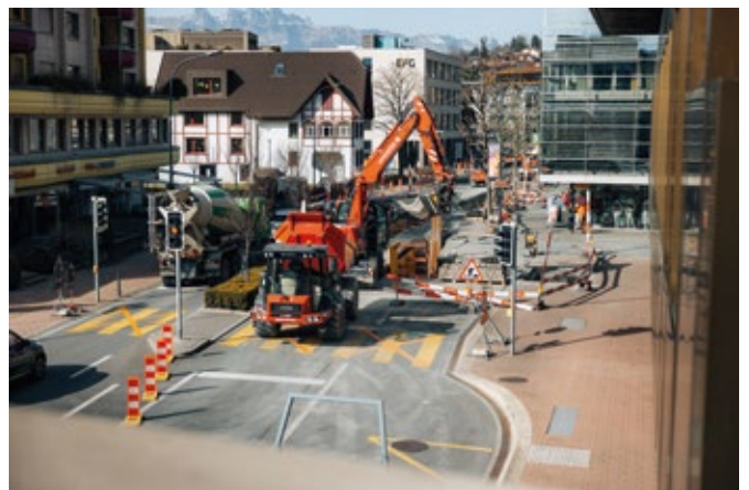
Der Verkehr wird einspurig durch die Baustelle geführt.
