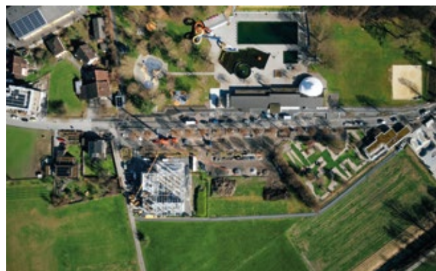
Der Baustellenbereich in der Schaanerstrasse aus der Vogelperspektive.
