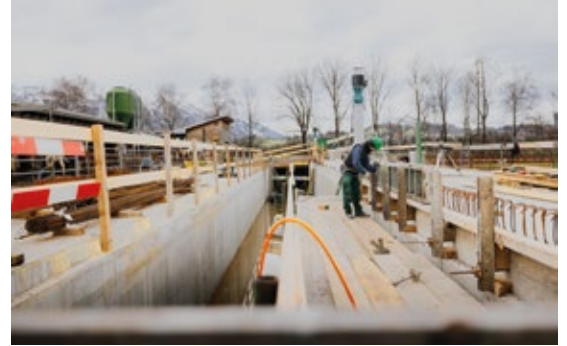
Bis Juli 2026 sollen die Bauarbeiten abgeschlossen werden.
